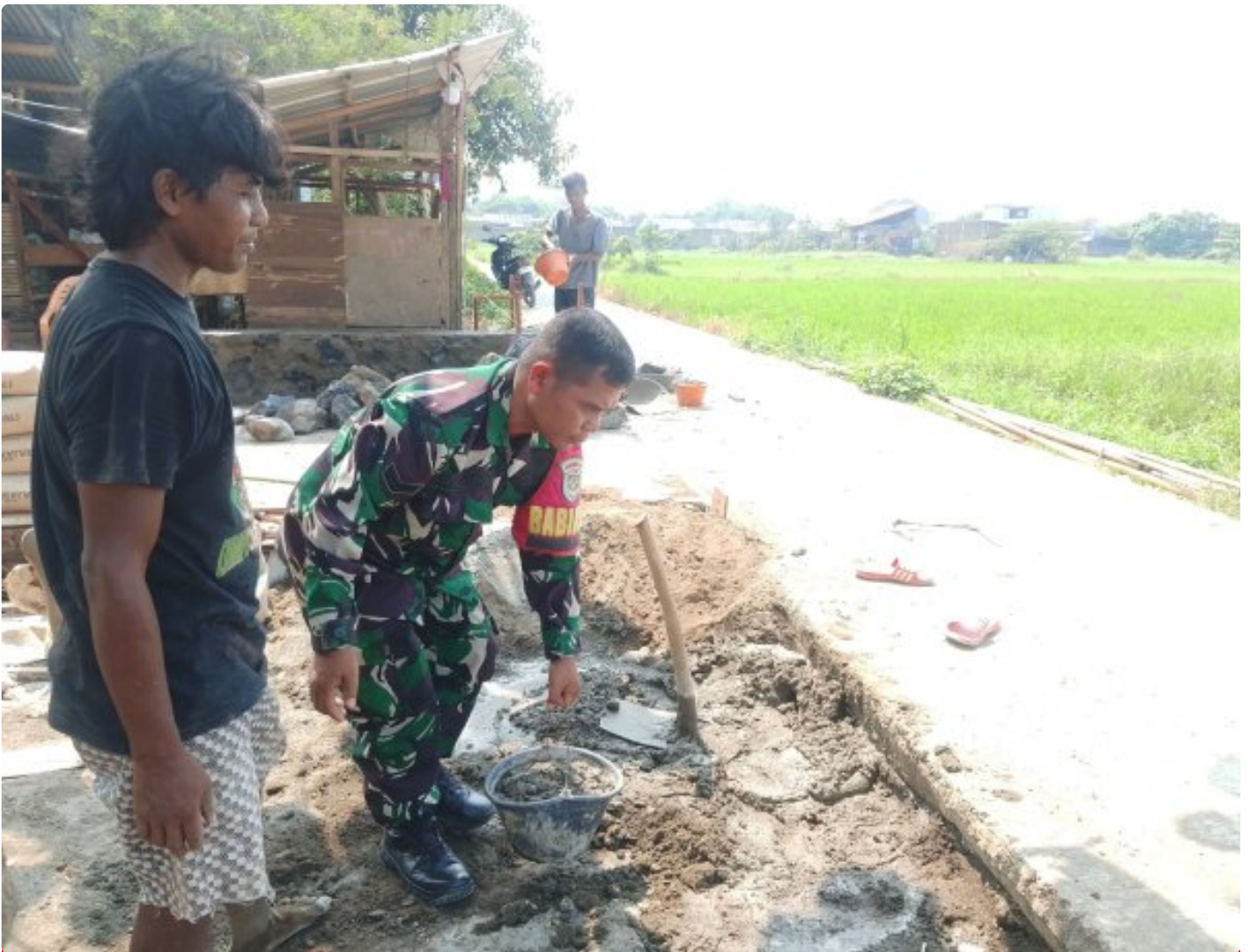
foto babinsa melaksanakan perbaikan jalan
